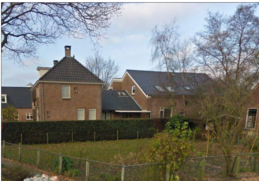
Zijaanzicht woning nr. 75 met aanbouw en woning nr. 73
