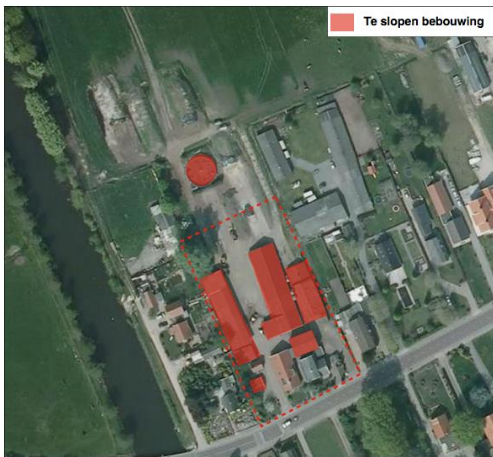
Afbeelding 3.1: Te slopen gebouwen op locatie Hammerweg 146
