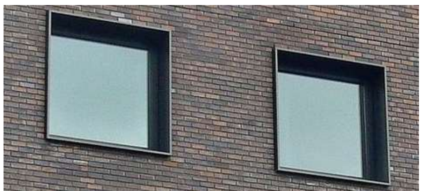
Nieuwe kozijnen worden antraciet en krijgen een antraciet kader (vlak met metselwerk). Bij het observatorium wordt dit wit.
