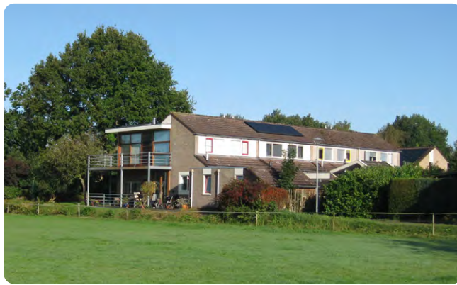
Kopwoning De Vennen met overhoekse uitbouw
