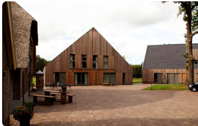
Woonschuren rondom verharde collectieve buitenruimte
