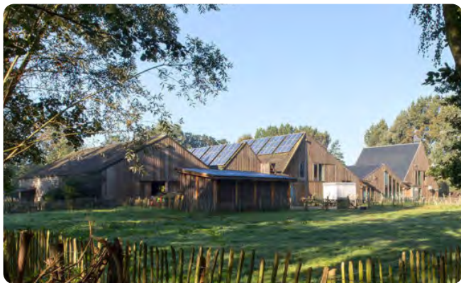
Meerdere functies onder één dak
