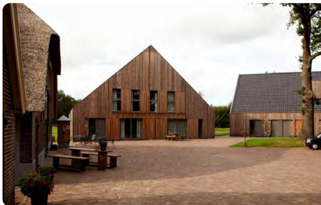
Woonschuren rondom verharde collectieve buitenruimte
