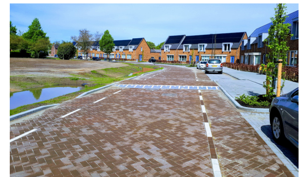
Oppervlakkig afwateren in de openbare ruimte
