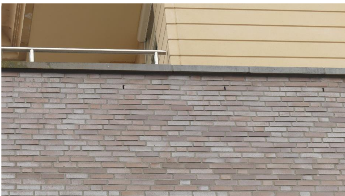
Figuur 6. Voorbeeld van open stootvoegen in binnenstad Roden.
