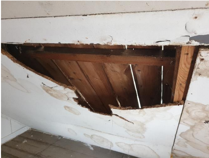
Figuur 16 In Gebouw 1 is onder het dak ruimte aanwezig voor een mogelijk steenmarterverblijf.
