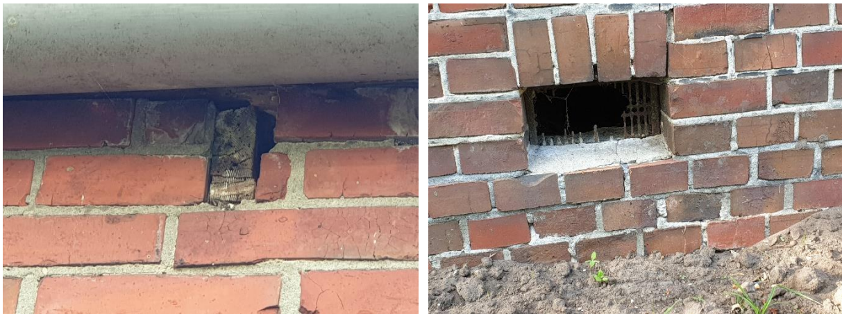
Figuur 14 Potentiele invliegopeningen voor vleermuizen bij afbrokkelende metselwerk (links) en een beschadigd ventilatierooster (rechts)
