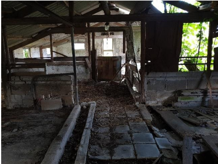
Figuur 13 Voormalige stal aan het Baggelveld 9 te Terheijl (Nietap).
