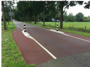
Figuur 2.8 Huidige situatie Achteromweg
