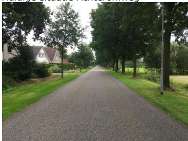
Figuur 2.7 Huidige situatie Achteromweg
