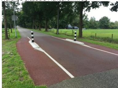
Figuur 2.8 Huidige situatie Achteromweg
