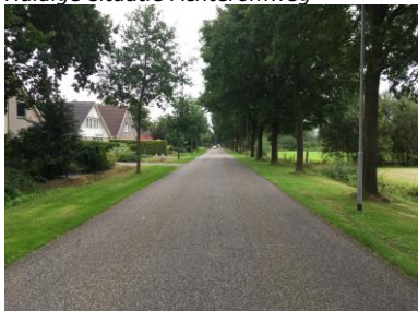
Figuur 2.7 Huidige situatie Achteromweg
