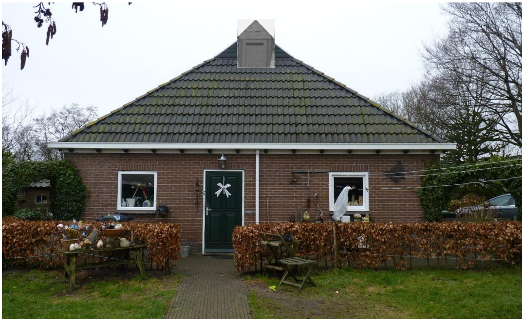
Figuur 18 Impressie van de oostgevel Achteromweg 3 met dakkapel voor grootoorvleermuizen.
