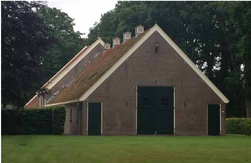
Kopgevel middenhuisboerderij; symmetrie, hoogte accent en ventilatieshoorsteen
