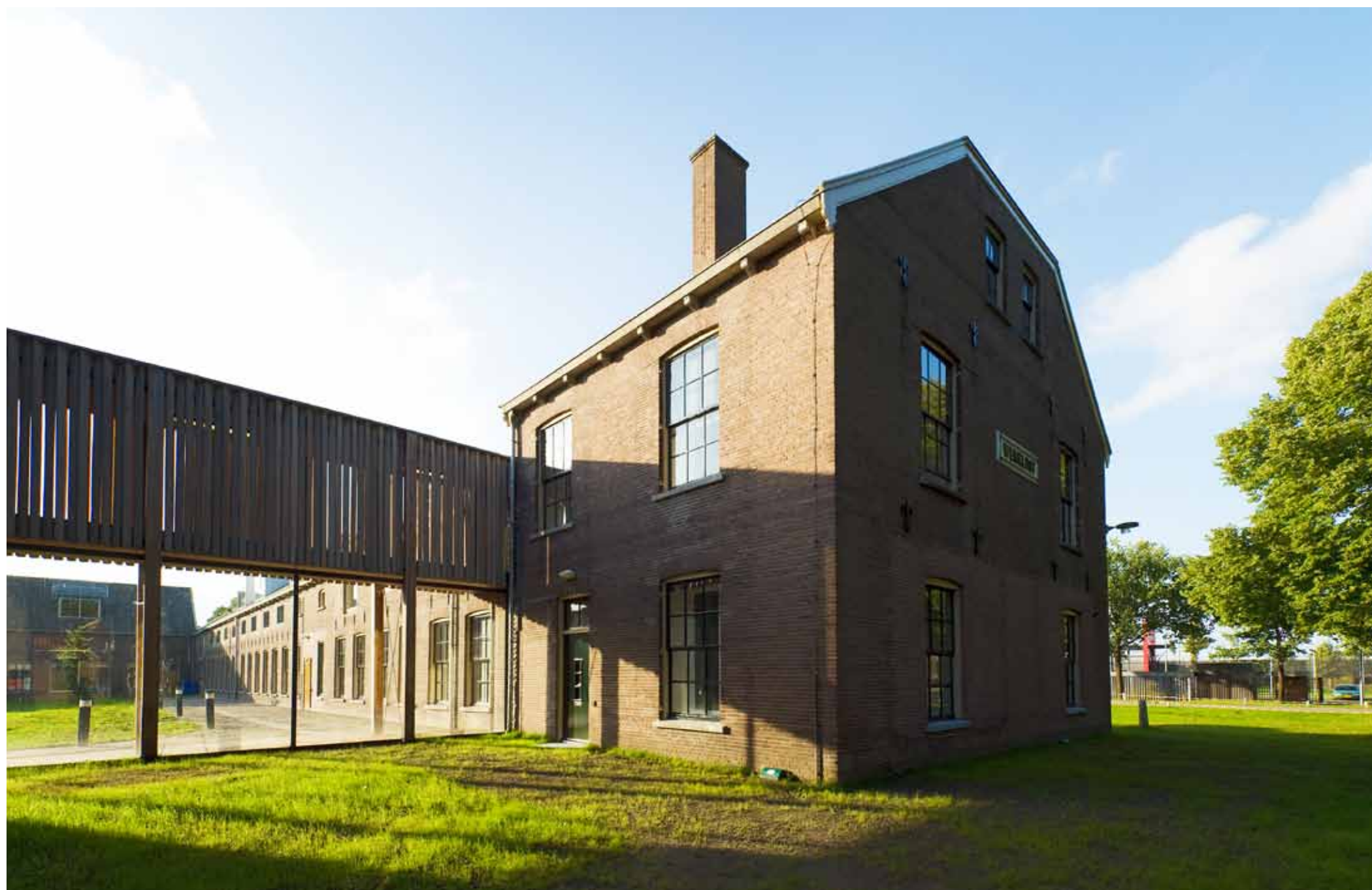
Uit 1884 stammend werkgesticht Norgerhaven, een rijksmonument, oorspronkelijk ontworpen door W.C. Metzelaar. In 2008 door DAAD Architecten getransformeerd tot Shared Service Center.
