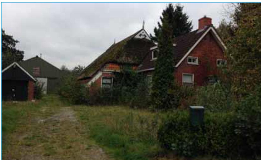
Figuur 2.3: De woonboerderij op het perceel Baggelveld 6 met links op de achtergrond de inmiddels gesloopte opstallen
