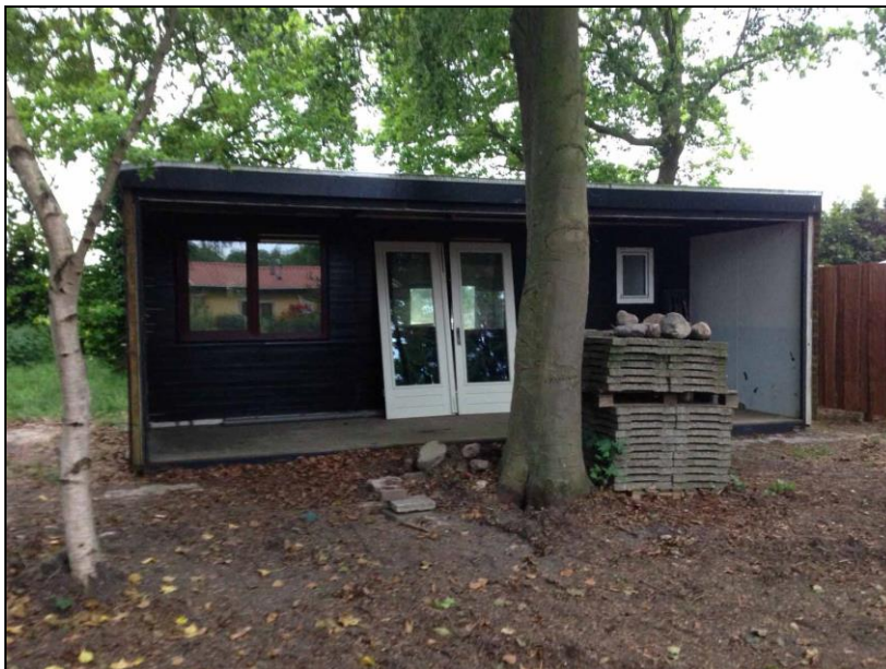
Figuur 5: Aanzicht oorspronkelijke situatie
