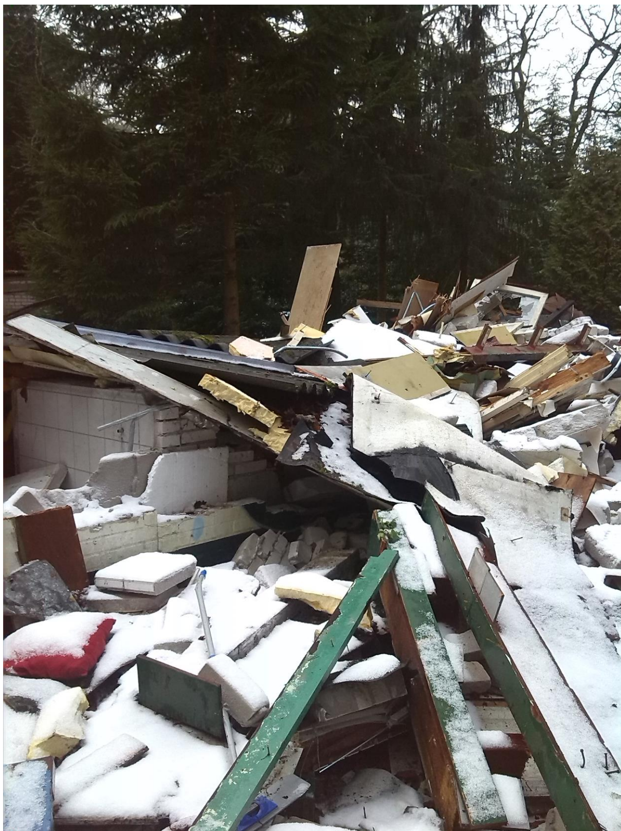
Foto 3: deels afgebroken bebouwing (niet toegankelijk voor onderzoek)
