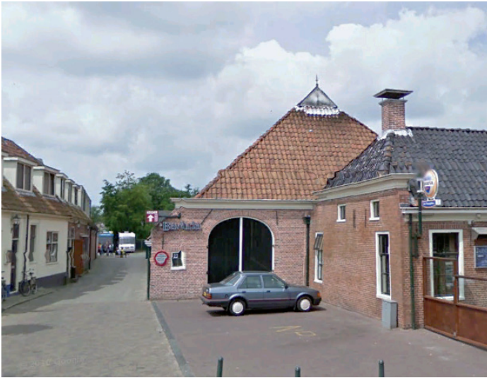
Brink 21 Boerderij met Friese schuur. Inrijpoort onder gemetselde segmentboog. Woongedeelte dwars uitgebouwd met lange gevel aan de weg.
