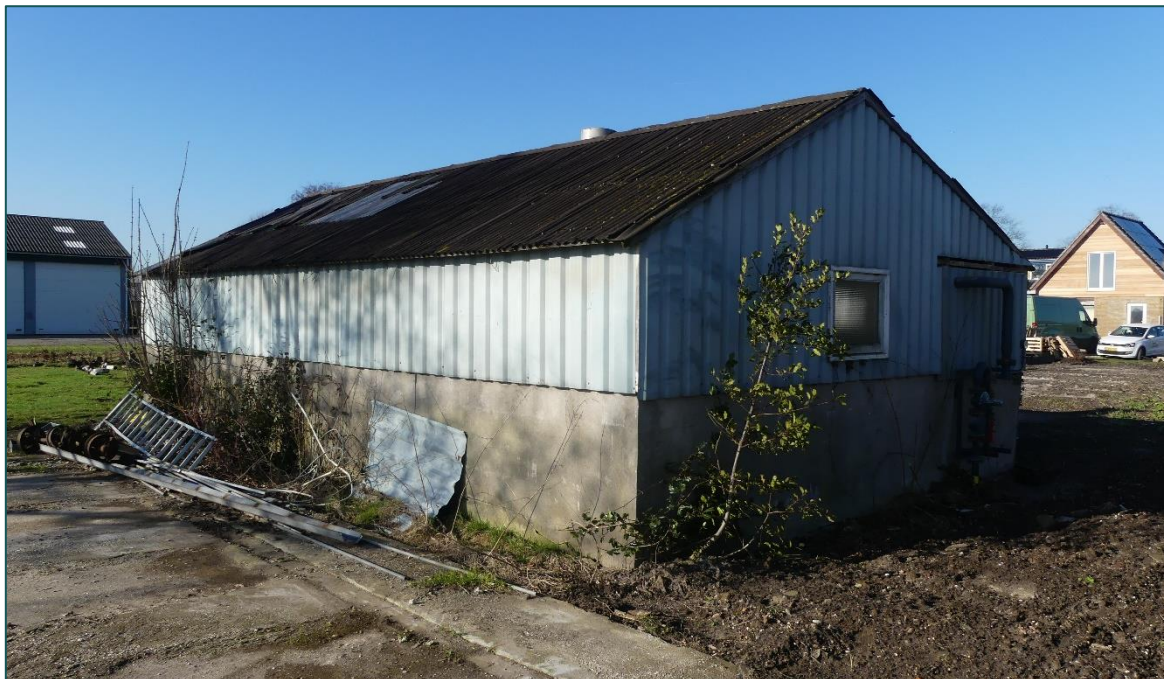
Figuur 1 De planlocatie is gelegen aan de Middenweg 42 te Nederhorst den Berg en bestaat uit een schuur. De beoogde ruimtelijke ingreep betreft de sloop van de bebouwing voor nieuwbouw. De foto geeft de zuidoostzijde van de schuur weer, aan de linkerzijde van het dak is de beschadigde dakbedekking zichtbaar
