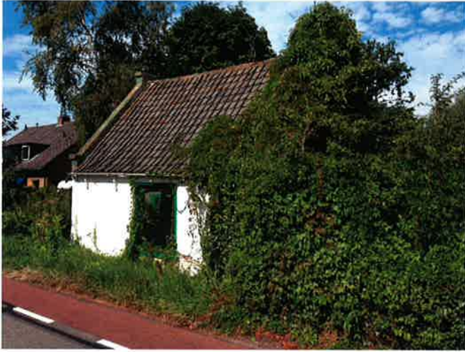
voorgevel aan de dijk
