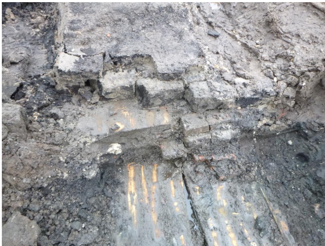
Afb. 18. De houten fundering van de turfblokken ligt minder diep dan de funderingsplanken van de bakstenen fundering (op de voorgrond).
