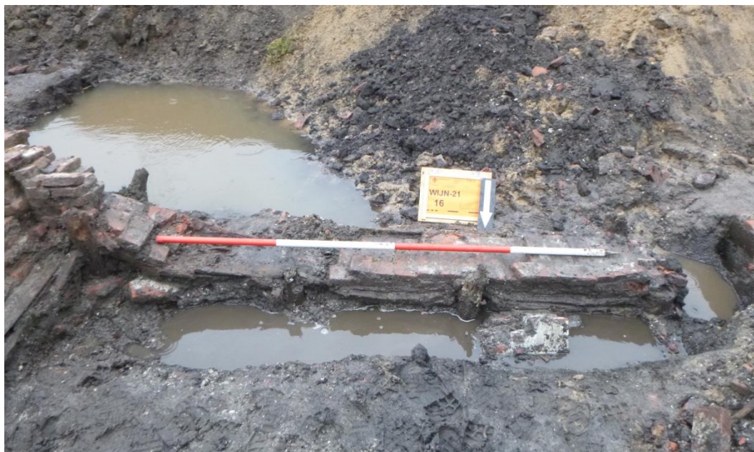
Afb. 19. De zuidelijke fundering van het gebouw met paaltjes aan weerszijden hiervan.
