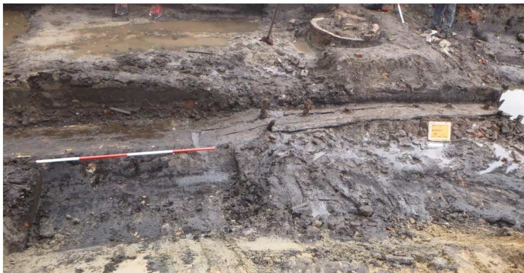
Afb. 14. De bakstenen fundering kende twee verschillende houten funderingswijzen die twee verschillende bouwfasen lijken aan te duiden.
