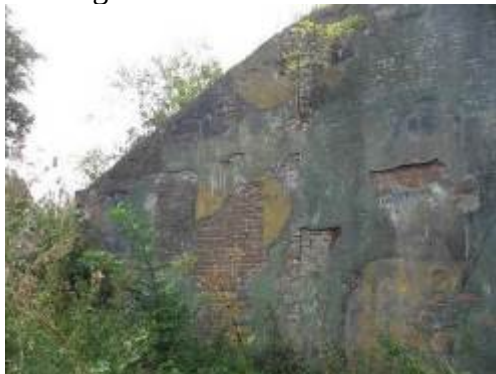
Pleisterwerk incl. camouflage wordt hersteld.
