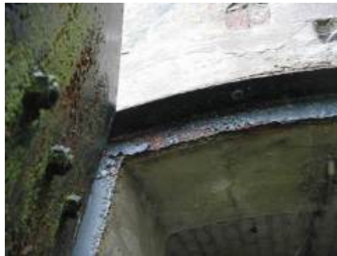
Herstellen deuren en schilderwerk.
