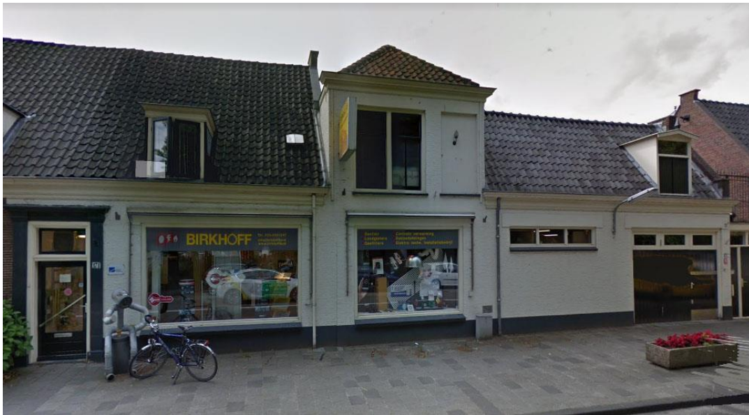
Afbeelding 3: De huidige situatie vanaf het Noordereinde.
