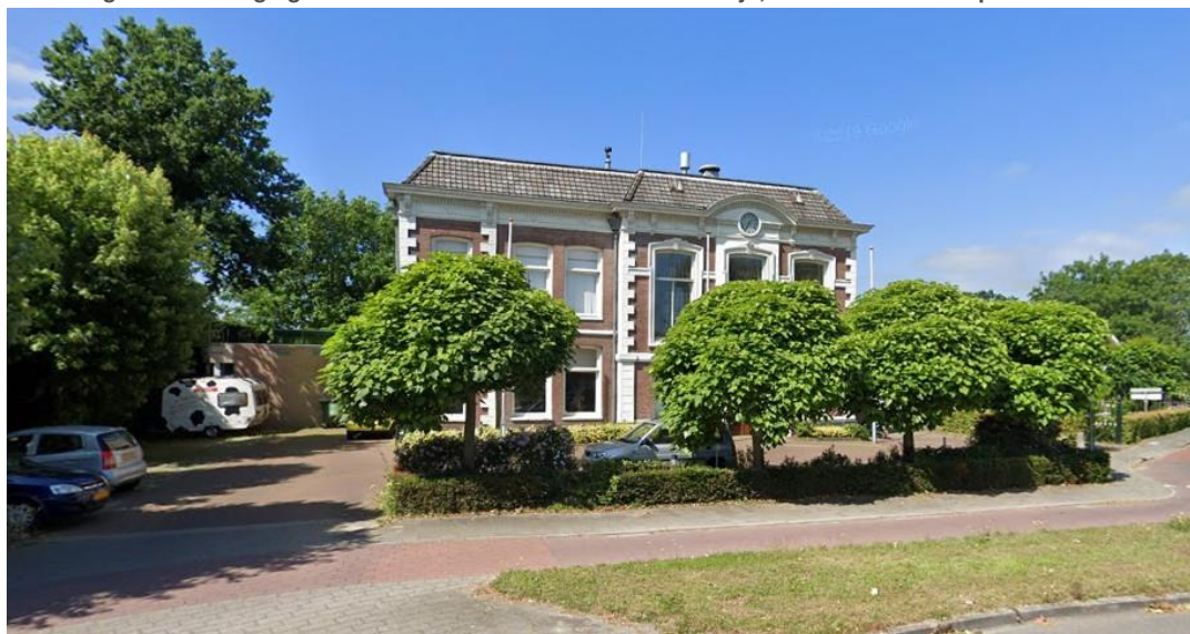
Afbeelding 1: Het huidige gebouw vanaf de Nieuw-Loosdrechtsedijk, met links de te slopen aanbouw.
