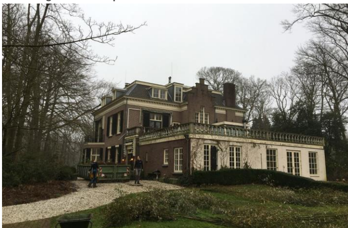
Afbeelding 3: De te slopen aanbouw vanuit het zuidwesten.
