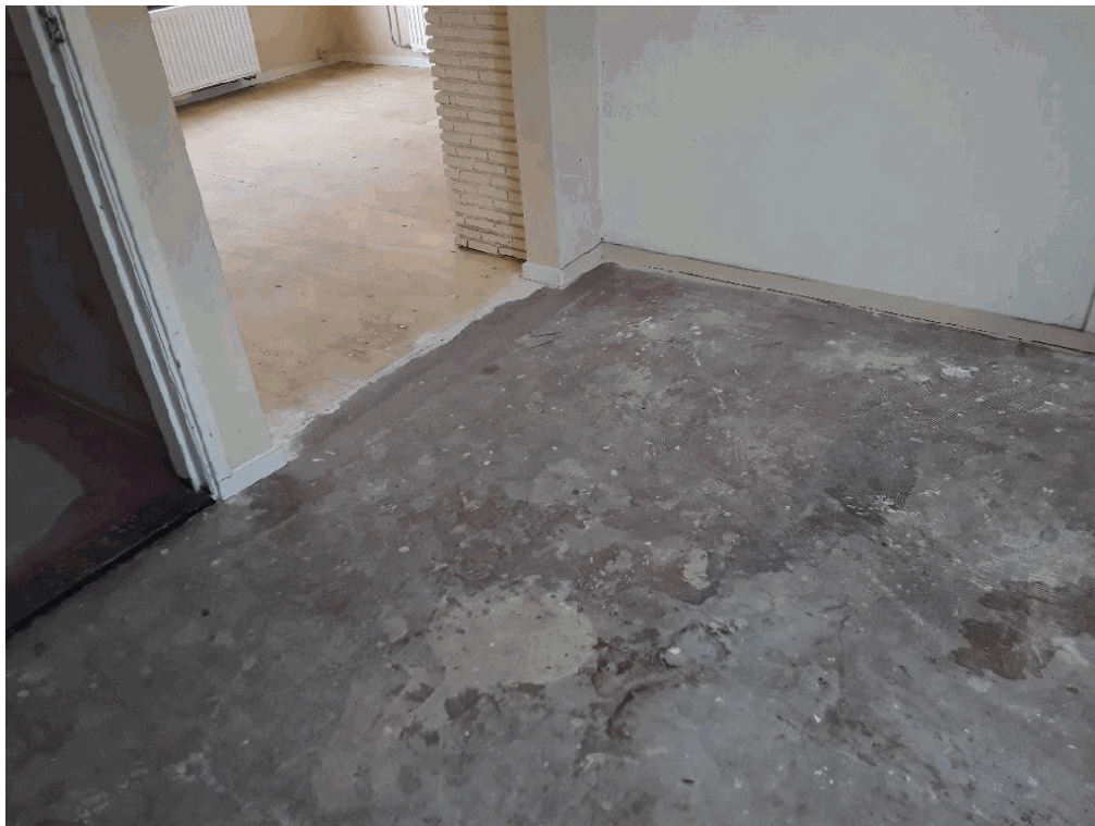
Geen verdachte vloerafwerkingen op de begane grond.
