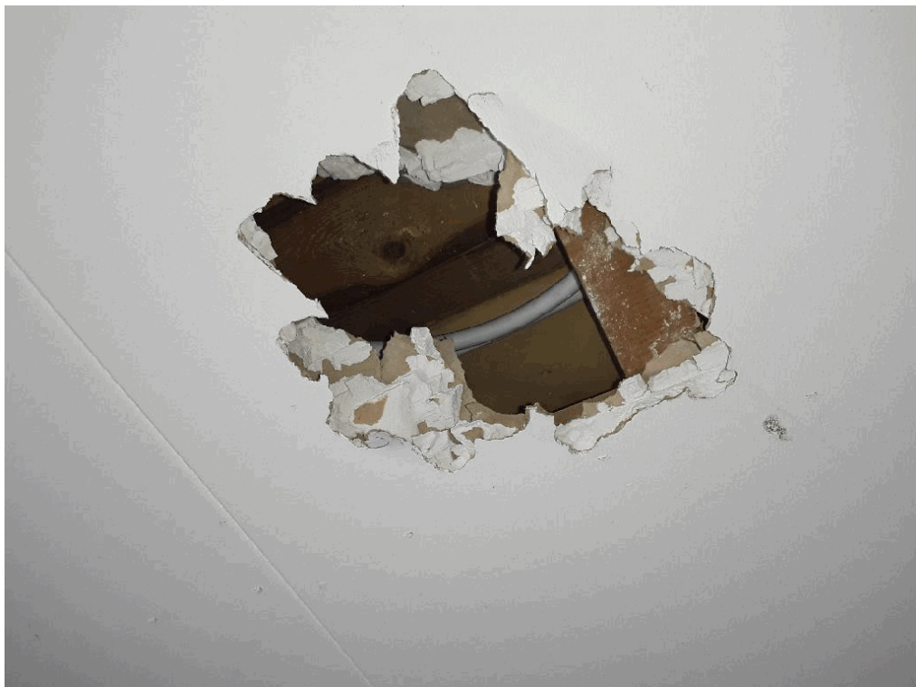
Geen verdachte elementen boven het systeem plafond op de 1e verdieping.
