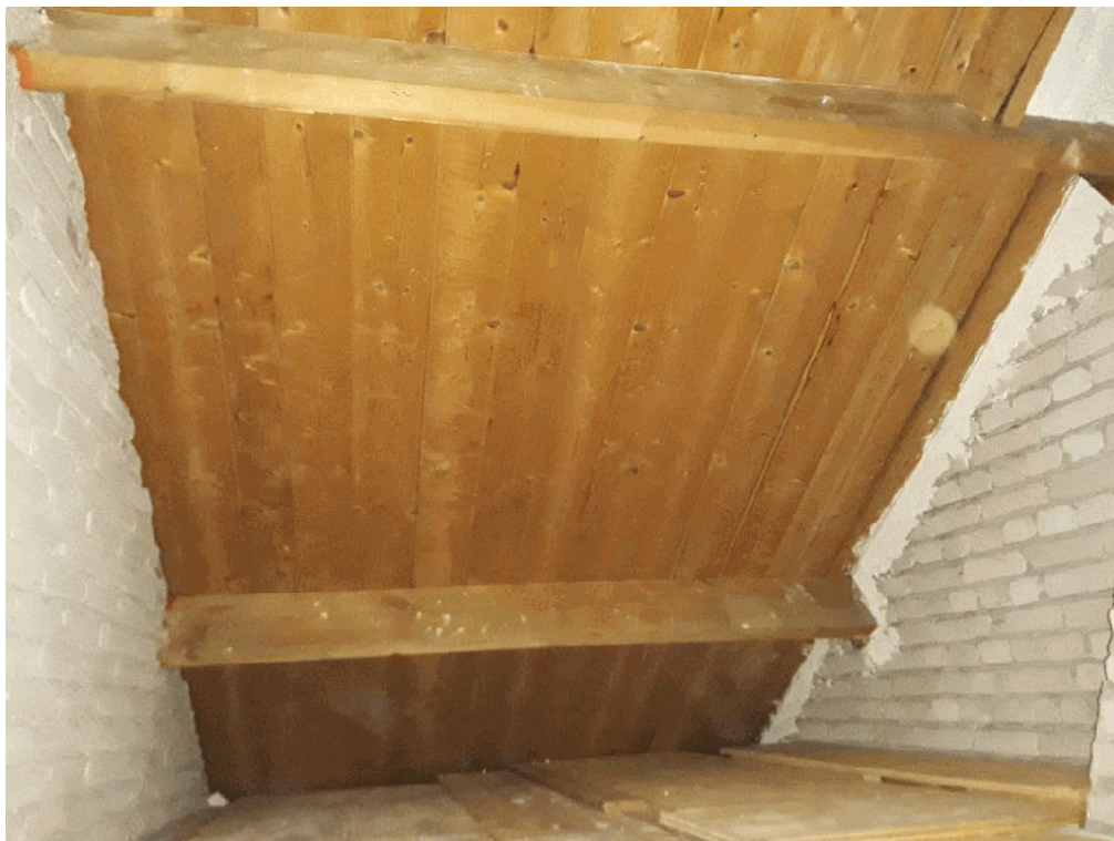
Geen verdacht dakbeschot op zolder.
