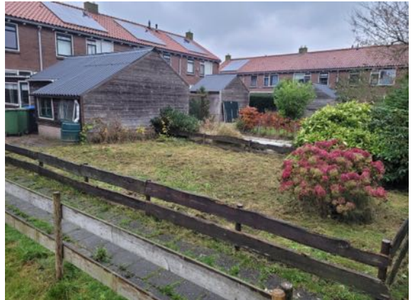
Figuur 6. Achterzijde van de woningen aan de zuidkant van de straat.
