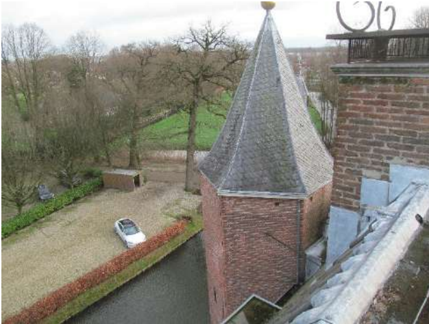
Torenspits met leien en zijde van het dak met pannen gedekt. Schoorsteen met rookplaat en tralies.
