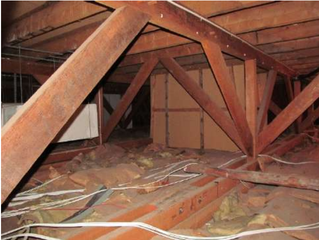
Zolderruimte onder het platte dak
