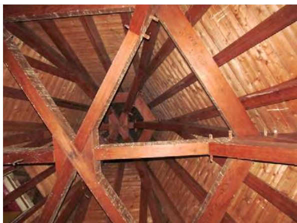
Torenzolder met leeg kraamverblijf 5-8-2021
