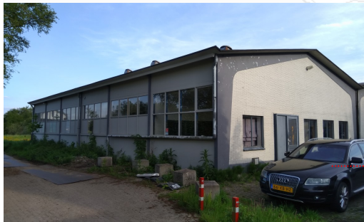
Voormalige wasserij Behorend bij bedrijfswoning
