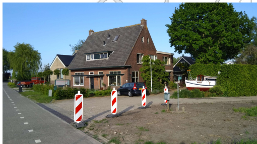
Samenvallen toegang Met noordelijke belending
