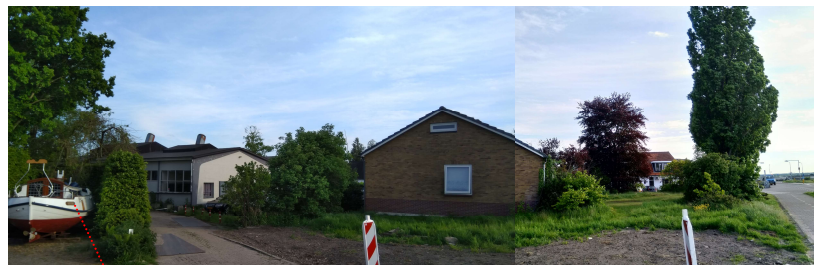
Bedrijfswoning zicht vanaf Dammerweg noorden
