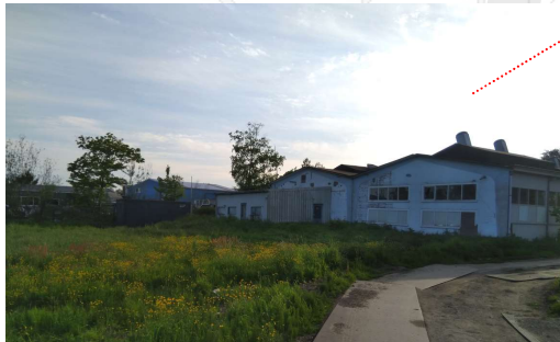
Voormalige bedrijfshal Met braakliggende grond
