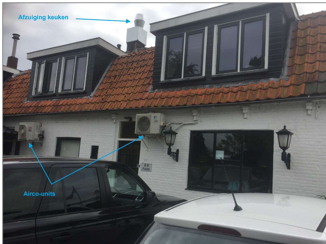
Figuur 2.4 Foto van de airco-units en afzuiging van de keuken op het dak
