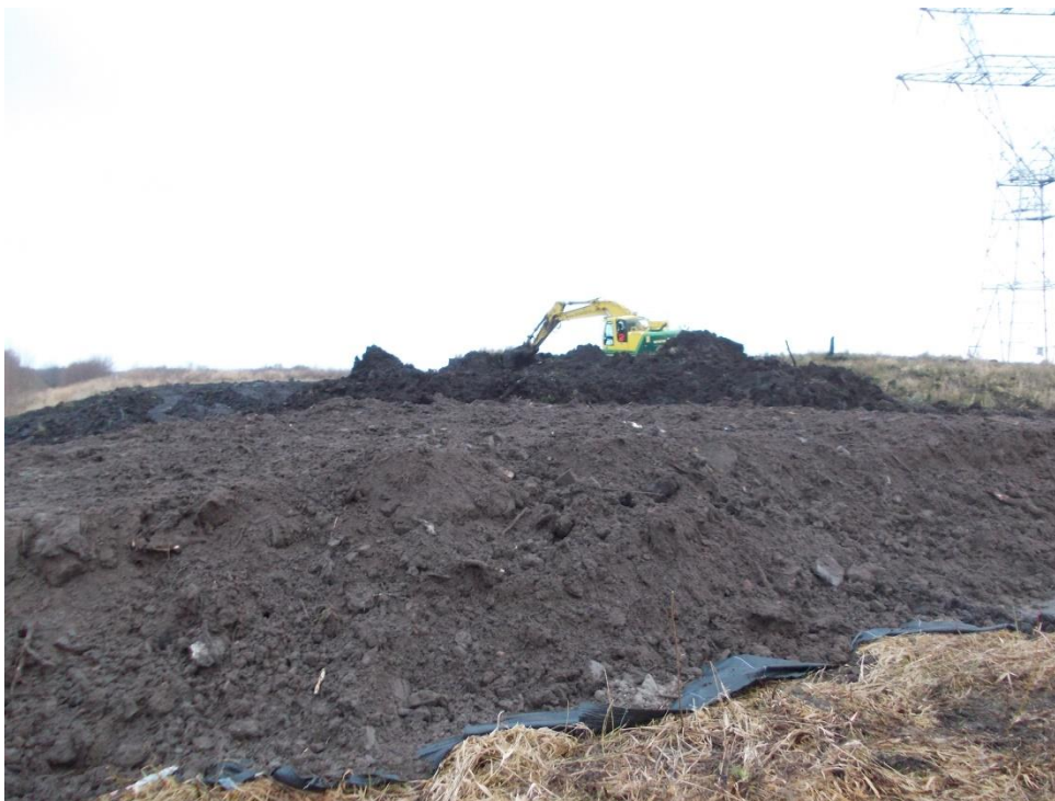
Foto 10: Zicht op scheidingsdoek tussen stort en partij R.13.0153.
