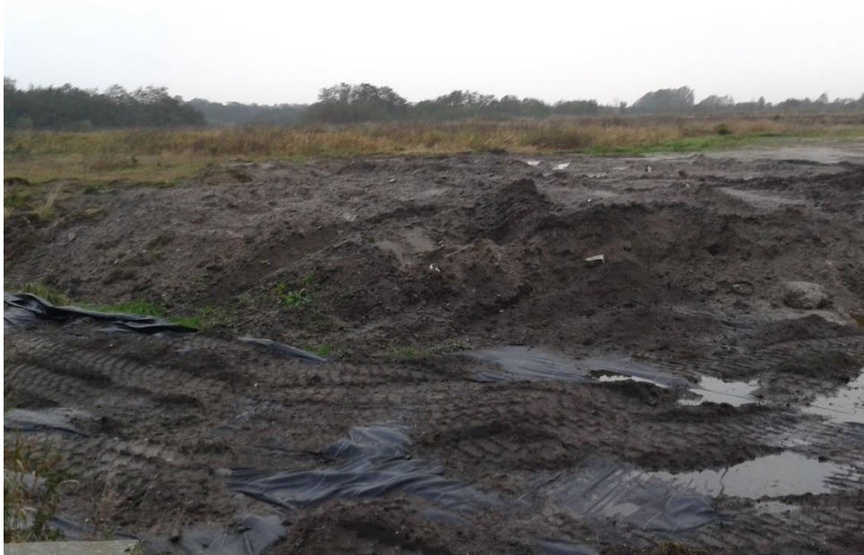
Foto 9: Zicht op scheidingsdoek tussen stort en partij R.13.0162.
