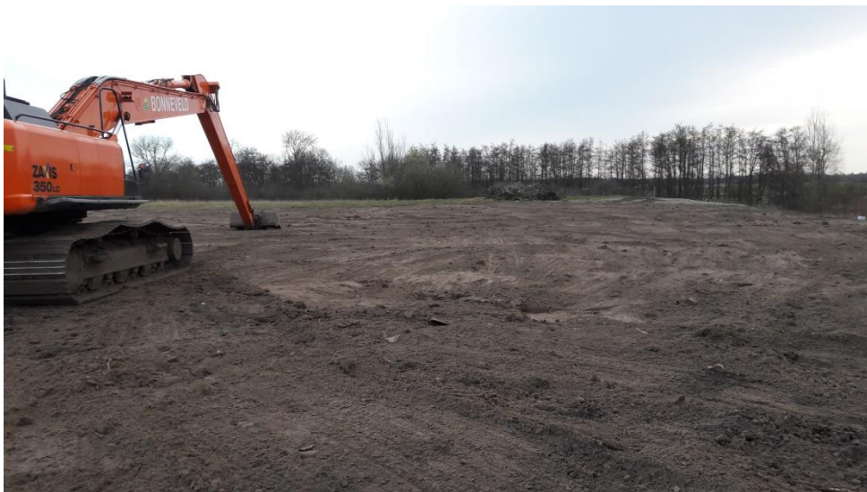
Foto 12: Zicht op afwerking leeflaag (maart 2017).
