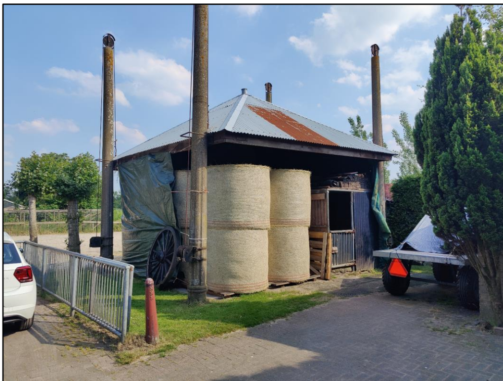
Figuur 1 De beoogde ontwikkeling betreft het transformeren van de hooimijt naar een woning en het saneren van een tuinhuisje.
