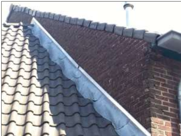
Gevelpannen vormen een potentiële invliegopening voor vleermuizen.
