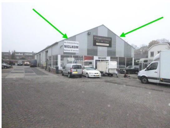
Cannenburgeweg 7C: Foto 4 | Foto voor bron Golfplaten en vormstukken
