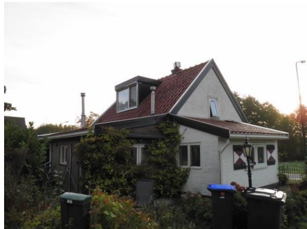
Figuur 4. De woning heeft aan de achterzijde een dakkapel en aan twee zijden een uitbouw.
