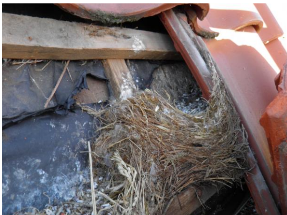
Figuur 7. Eén van de gebruikte nesten van Huismus op het dak van de woning.
