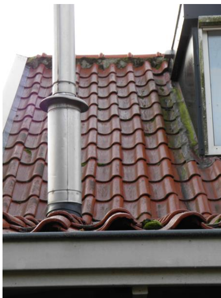
Figuur 10. Het dak aan de achterzijde van de woning met de uitbouw.
