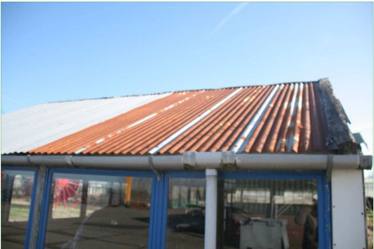
Tochtige schuur met golfplaten dak is niet geschikt voor vleermuizen.
