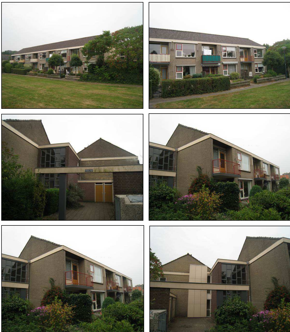
Figuur 2. Aanzicht van het de te renoveren woningen aan de Godelindehof te Nieuw-Loosdrecht (september 2014).
