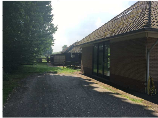
Bestaande situatie achterste bedrijfsloods met hooiberg
