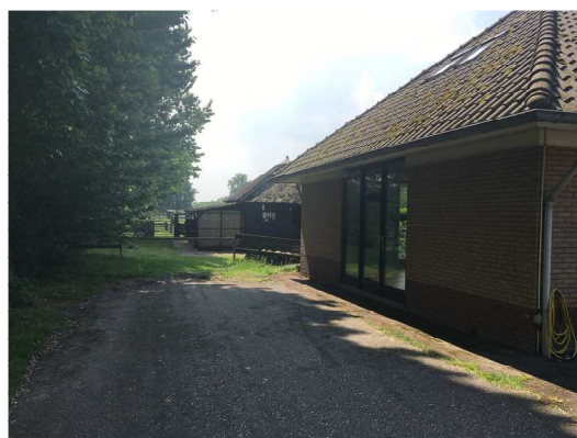
Bestaande situatie achterste bedrijfsloods met hooiberg
