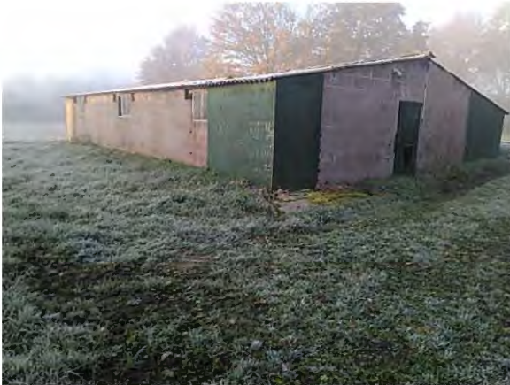
Figuur 7: Overzichtsfoto bebouwing
