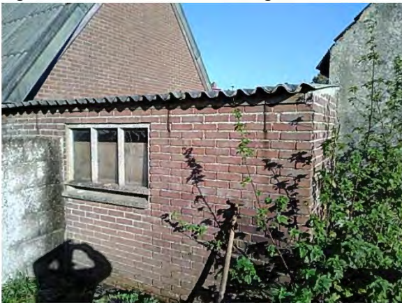
Figuur 9: Overzichtsfoto bebouwing
