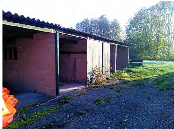
Figuur 10: Overzichtsfoto bebouwing
