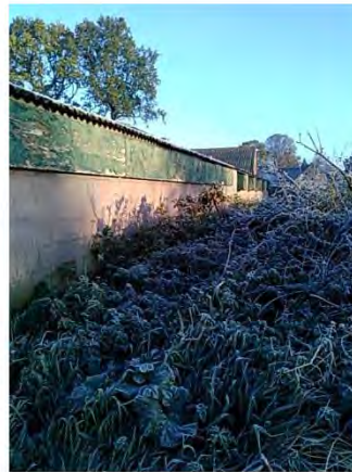
Figuur 8: Overzichtsfoto bebouwing
