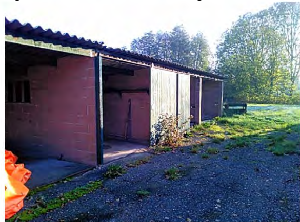
Figuur 10: Overzichtsfoto bebouwing
