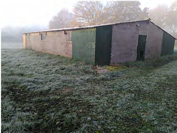
Figuur 7: Overzichtsfoto bebouwing
