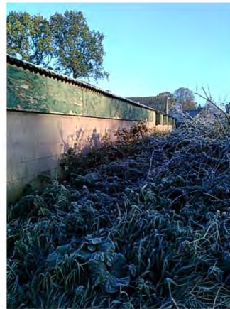
Figuur 8: Overzichtsfoto bebouwing
