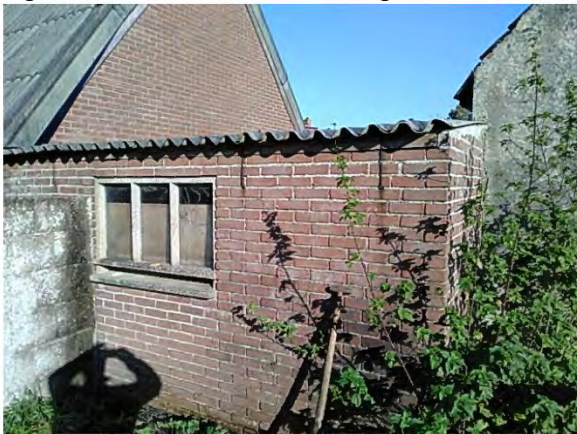
Figuur 9: Overzichtsfoto bebouwing
