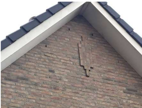
Open stootvoegen in de buitengevels van beide woningen. Alle gebouwen in het plangebied worden beschouwd als een potentiële verblijfplaats voor vleermuizen.
