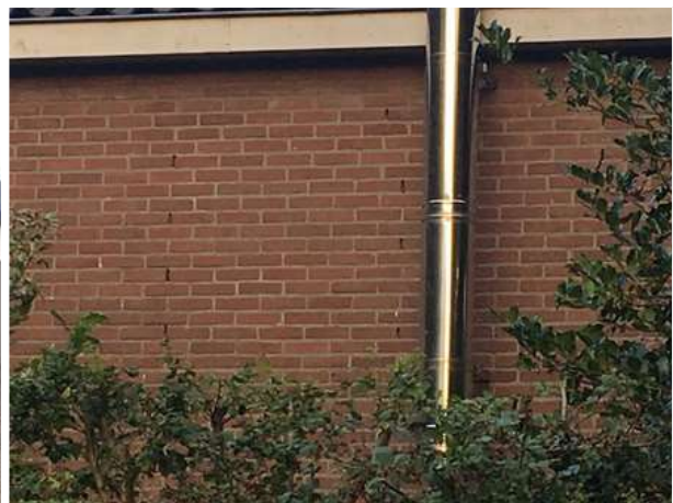
Open stootvoegen in de buitengevels van beide woningen. Alle gebouwen in het plangebied worden beschouwd als een potentiële verblijfplaats voor vleermuizen.
