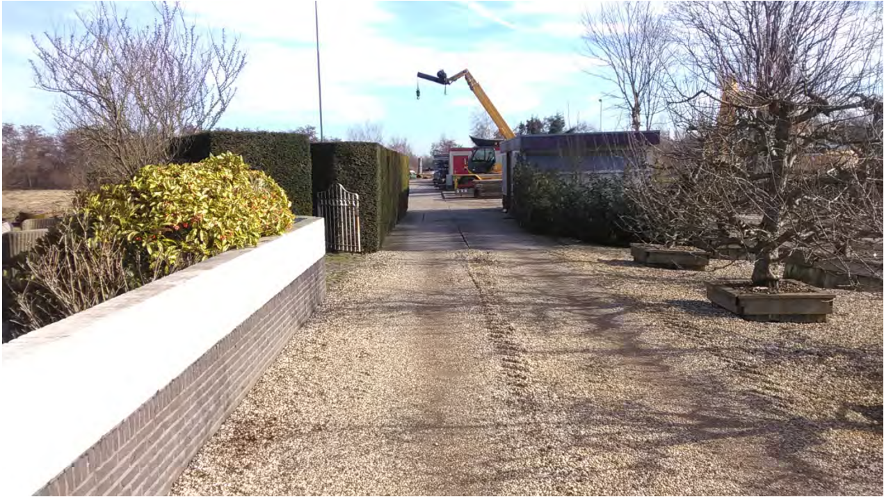
F10 Oprit naast de woning gezien kijkend in oostelijke richting
