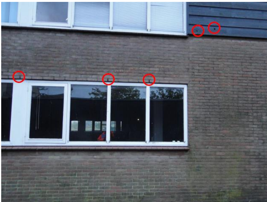
Figuur 4.1: Open stootvoegen en gaten (rood omcirkeld) in de gevel van de te slopen bebouwing
