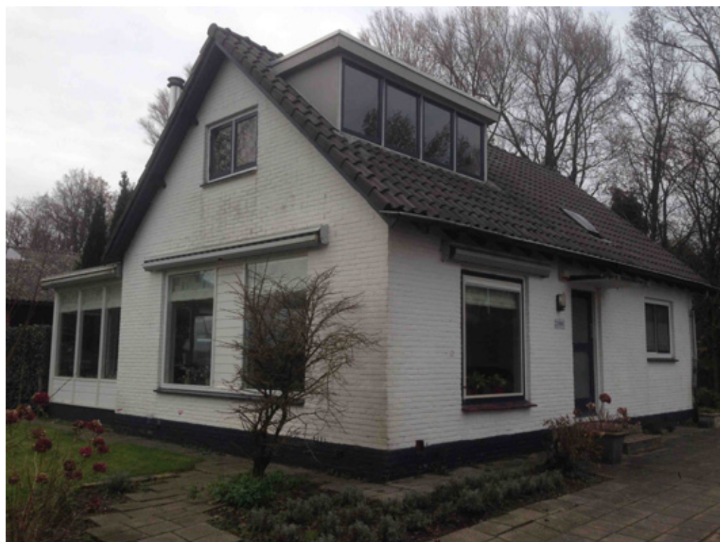
Figuur 2 De sloop van de bestaande bedrijfswoning maakt onderdeel uit van de beoogde transformatie. Langs de Nieuw-Loosdrechtse dijk is een nieuwe woning voorzien.
