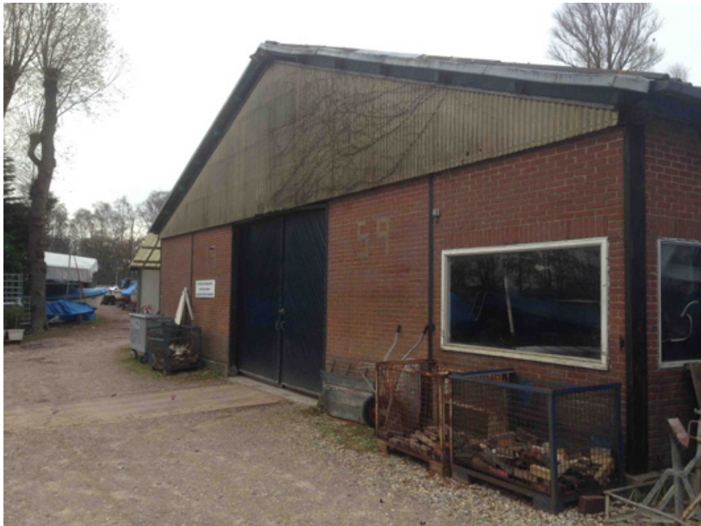
Figuur 3 De bestaande loods wordt gebruikt voor stalling van boten. De loods wordt gesloopt, op het achterliggende terrein is de nieuwbouw van een werkplaats voorzien.
