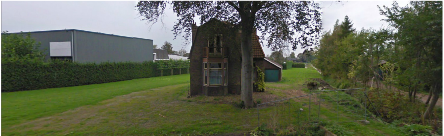
04 - beeld vanaf de Loodijk - huis aan de Loodijk 6 met doorzicht naar achteren;
