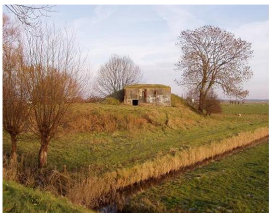
Afbeelding 4: Bunker en overzicht zuidelijk deel
