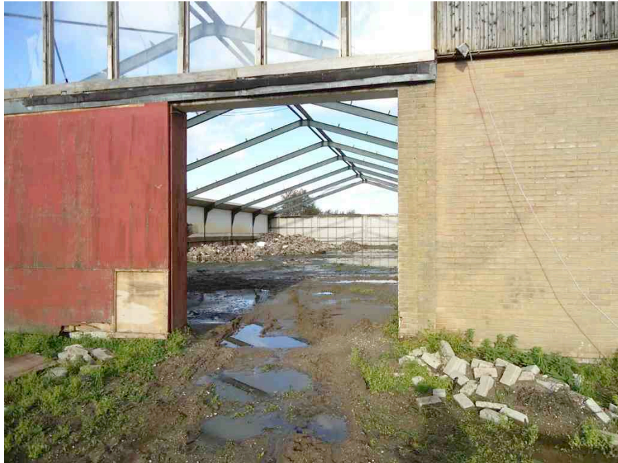
Figuur 3.7 Hal C. Het gebouw is al gedeeltelijk gesloopt.
