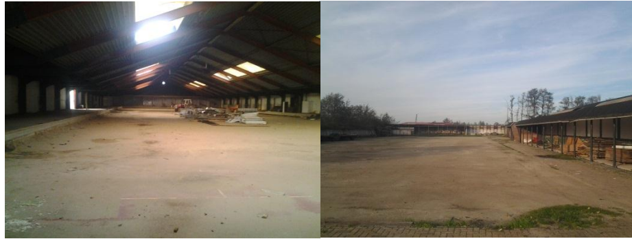
Figuur 3.4 Zicht op het geplande hoofdgebouw, de congreshal. Links voormalige tennisbanen binnen een te slopen hal, rechts een betonvloer buiten.
