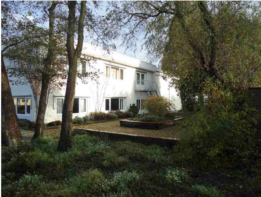
Figuur 1.2 Te handhaven gebouw (Hal A)
