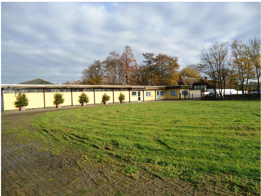
Foto 3 Zicht vanaf de westzijde op woning/stallen.
