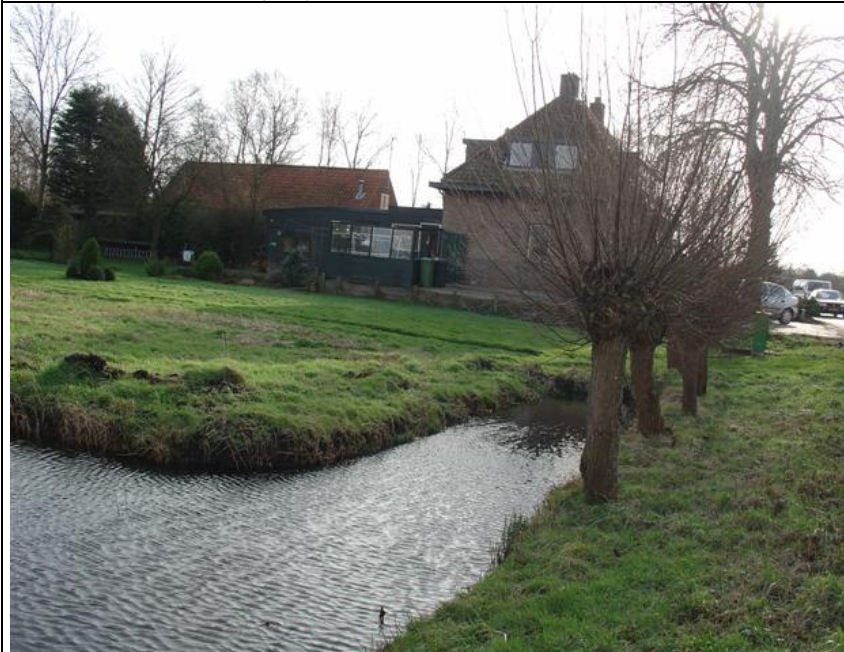
Foto 10. Woonhuis aan de Stichtse kade met bestemming bedrijventerrein
