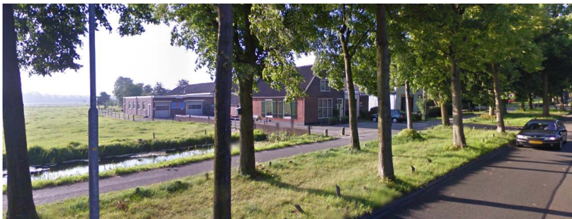
Figuur 2.1 Bestaande situatie (vanaf Zuidereinde in zuidelijke richting)
