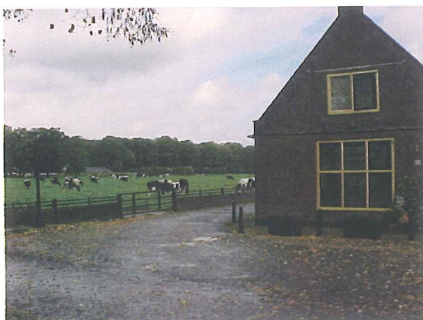
Foto 3: Woonhuis in noord-oostelijke richting vanaf de wegkant
