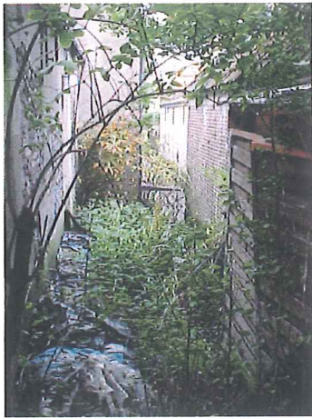
Foto 7: Sloop in westelijke richting
