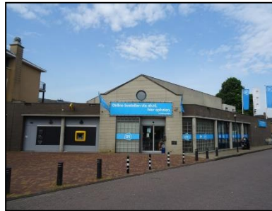
Figuur 7. Ingang kringloopwinkel gezien vanaf het oosten.
