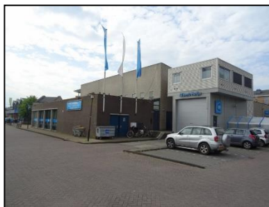
Figuur 3. Het winkelpand gezien vanaf het noorden.
