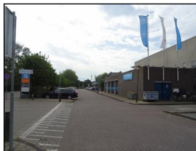
Figuur 4. Parkeergelegenheid aan de noordzijde van het winkelpand.
